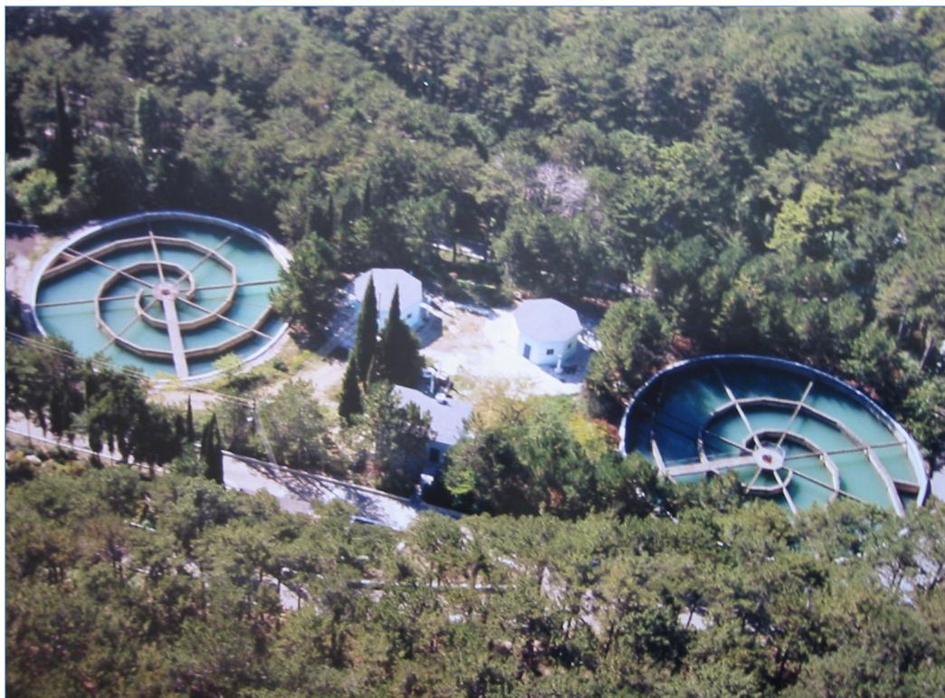
*Очистные водопроводные сооружения построены по проекту, разработанному институтом «Укрюжгипрокоммунстрой» г. Одесса. Первая очередь сооружений введена в эксплуатацию в 1964 году производительностью 51 тыс. м3/сутки, а вторая очередь – в 1982-1986 гг. Общая проектная производительность ОВС составляет 102 тыс.м3/сутки.*
