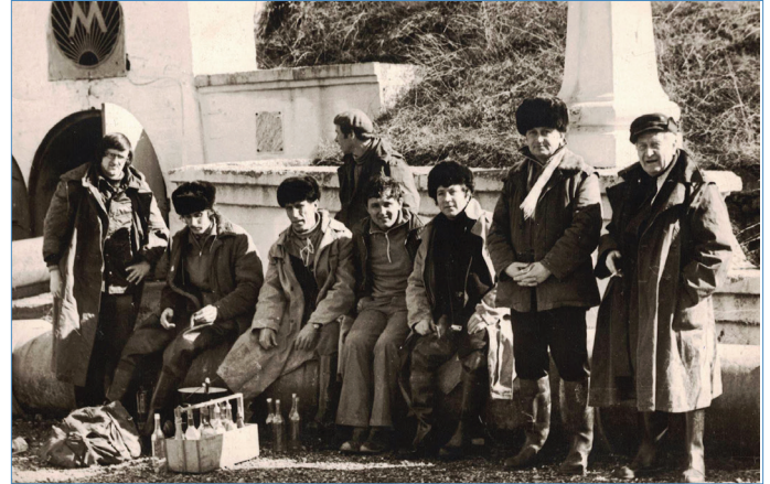
Обзор тоннельного водовода, Счастливицкий гидроузел 1979 г., четвертый слева — Евгений Балабанович
